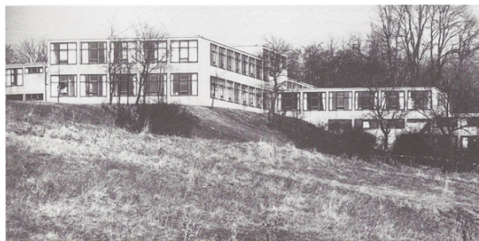
Figura 04. Prédio da HfG em Ulm – Alemanha. Fonte: (BÜRDEK, 2006)
