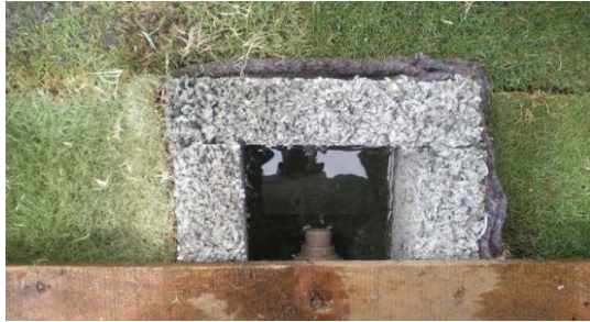
Figura 06 – Detalhe Lâmina d'água Sistema Laminar Fonte: www.ecotelhado.com.br
