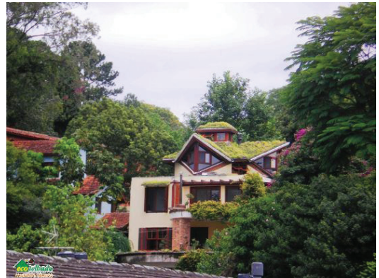
Figura 03 – Residência em Porto Alegre/RS Fonte: www.ecotelhado.com.br
