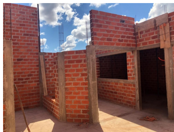
Imagem 3 – “OBRA X” (Vista interna)
