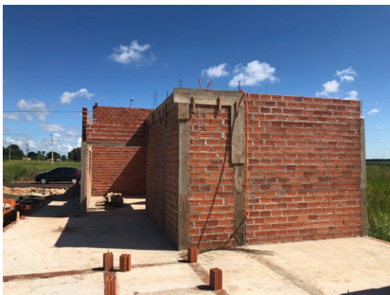
Imagem 4 – “OBRA X” (Vista Fundos)
