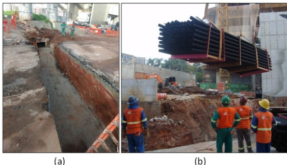
Figura 3 – Escavação (a) e montagem do banco de dutos (b)
