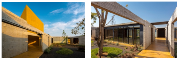
Figuras 3 e 4– Vista da integração com a natureza e o edifício
