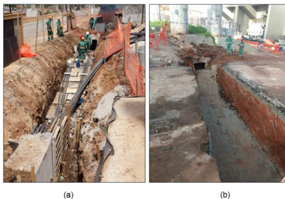
Figura 4 – Execução (a) e concretagem (b) do banco de dutos
